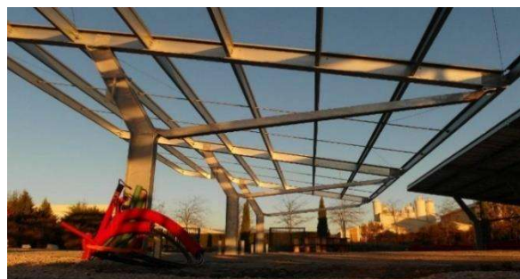
Figure 5 : Exemple d'ombrières fournies par HELIOWATT – (Source : Quadran)
