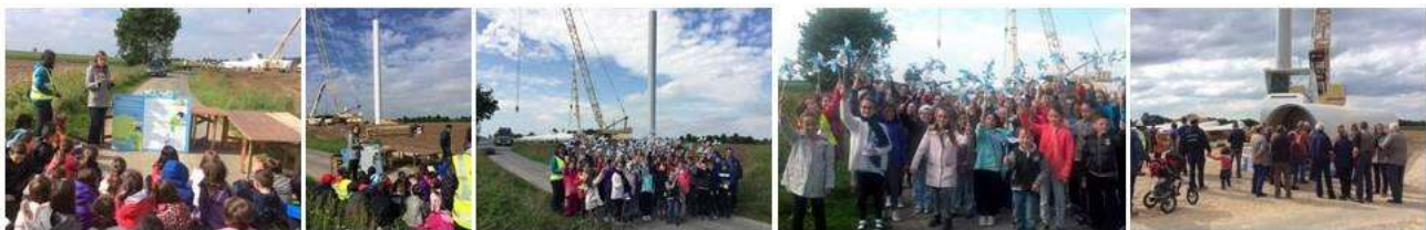
Figure 10 : Photographies de la visite de chantier à Treffendel Quadran
