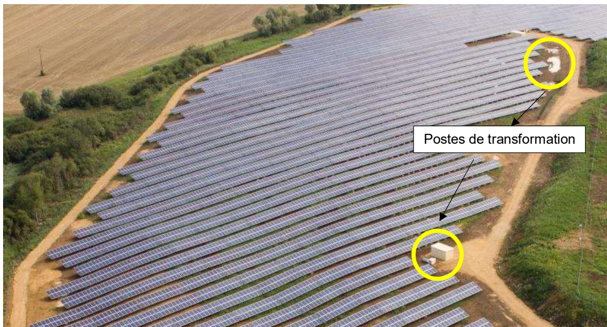
Figure 5 : Exemples de postes de transformation – Centrale de Boulogny (55) – (Source : Total Quadran)
