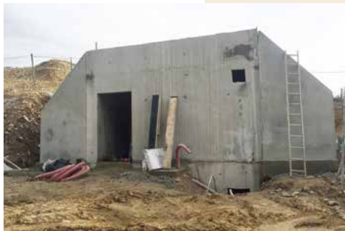
↑ La création de la station de pompage en cours sur la commune de Quenne.
