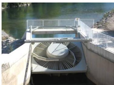
Les turbines VLH sont elles aussi basées sur la technologie des hélices Kaplan, adaptée aux aménagements de faibles hauteurs de chute, comprise entre 1.5 et 4.5 m, et avec un débit élevé de 9 à 27 m<sup>3</sup>/s. Ces turbines ichtyocompatibles sont équipées d'un dégrilleur rotatif intégré mais sont très encombrante et difficilement intégrable dans le paysage. De plus elles nécessitent de fort volume d'excavation.
