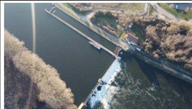
Le barrage est équipé d'un seuil de 65 m de large. La chute mesurée au droit du seuil le 21 janvier 2020 était de 1.87m.
