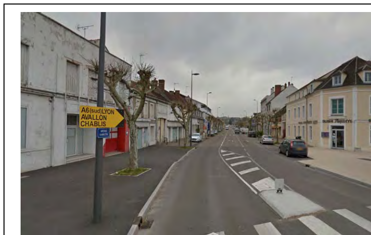
Habitations individuelles groupées secteur Ouest
