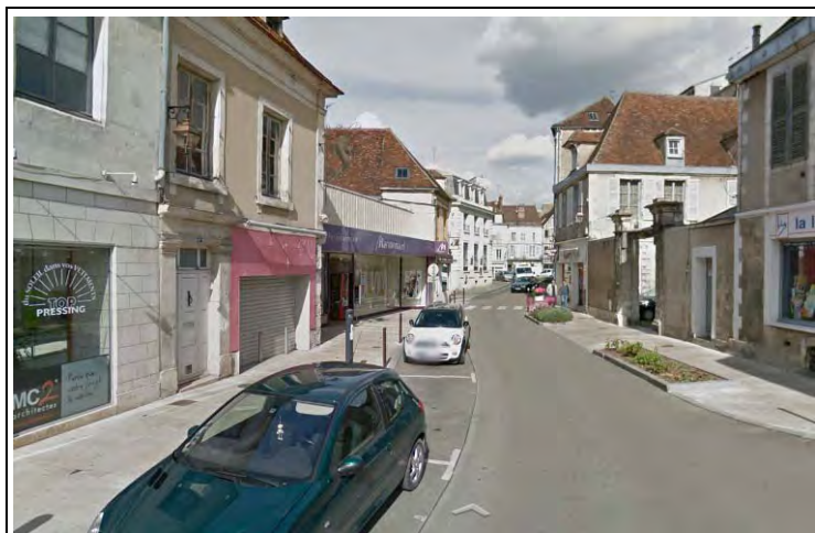
Habitations individuelles groupées secteur Ouest
