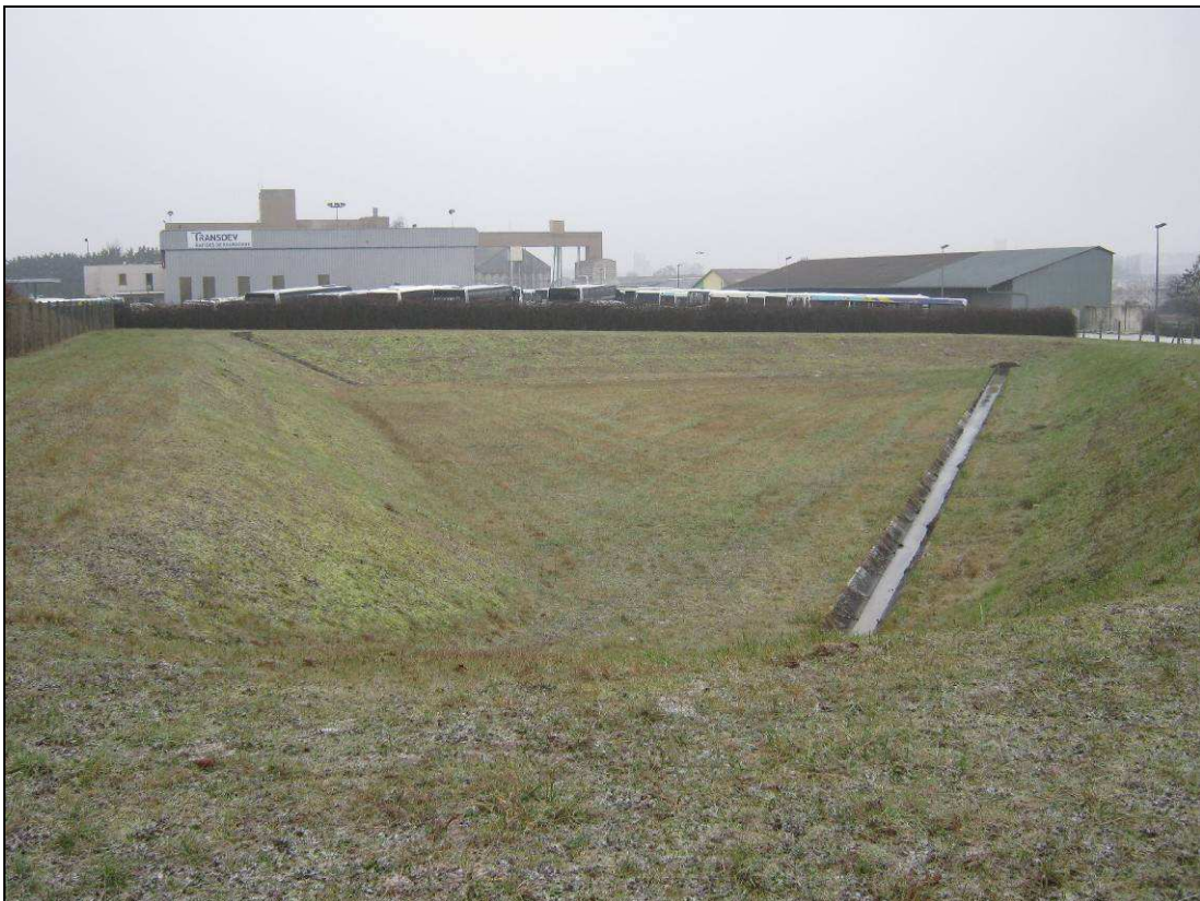
Figure 3-10 : Bassin d'orages pluvial des Mignottes (2 100 m 3 )
