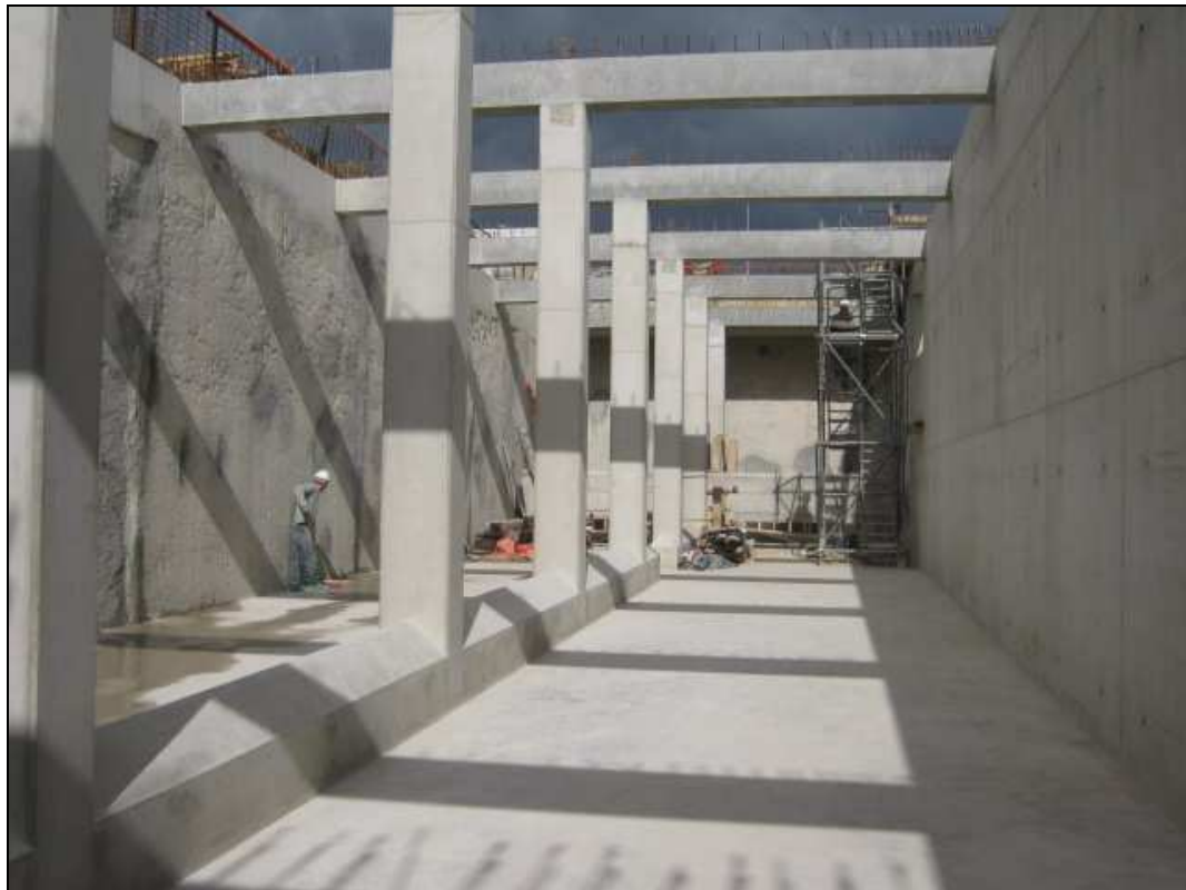
Figure 3-11 : Compartiment est du bassin unitaire de stockage/restitution de la Chaînette avant réalisation de la dalle de couverture (4000 m 3 )
