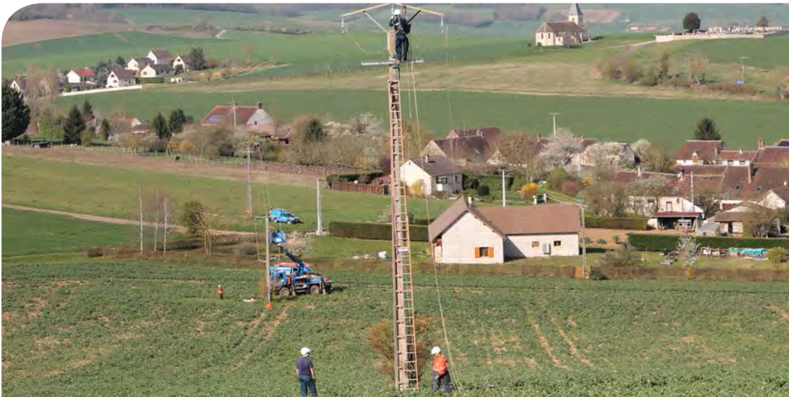
Travaux PDV à BEON
