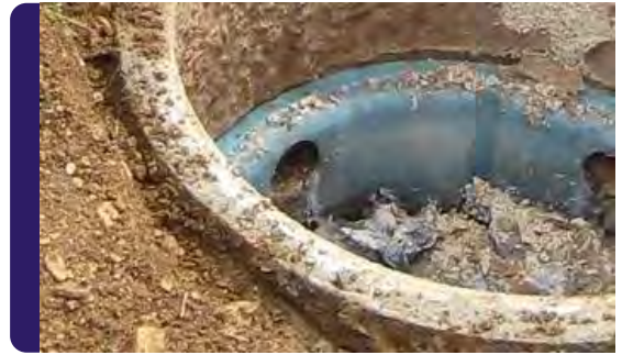
Bouche d'évacuation des eaux usées
