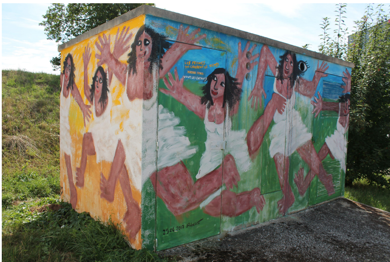
Poste de distribution publique d'électricité customisé dans le cadre des RADD 2017
