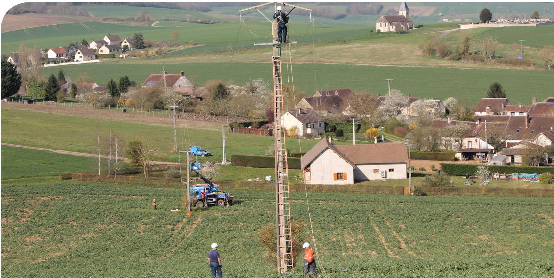
Travaux PDV à BEON
