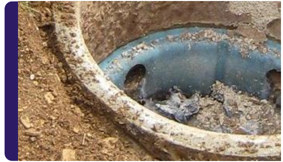
Bouche d'évacuation des eaux usées
