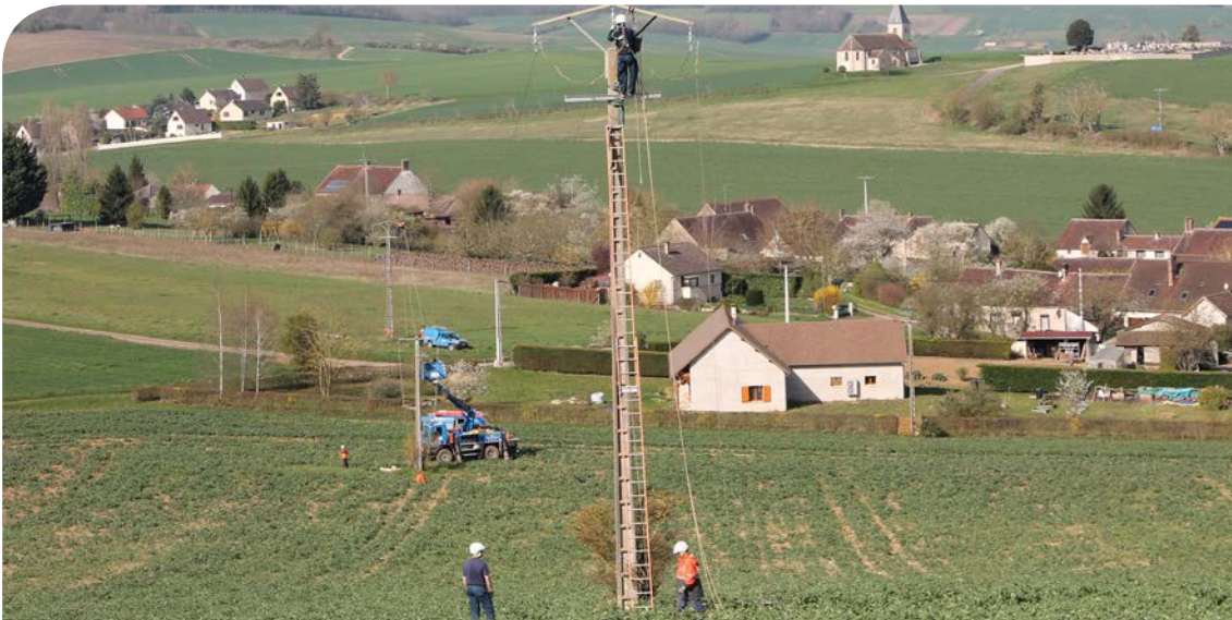
Travaux PDV à BEON
