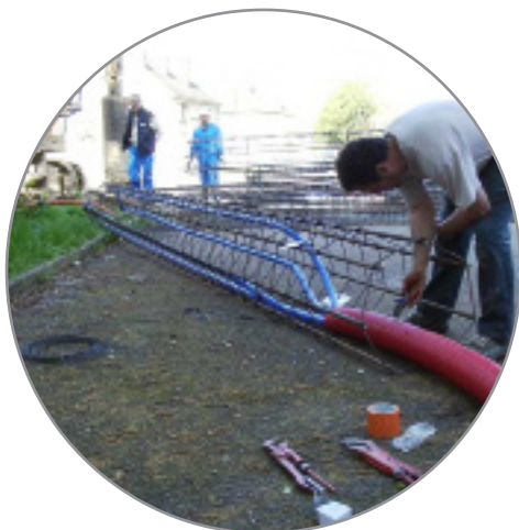
Préparation et mise en place des fondations thermoactives raccordées à la pompe à chaleur de la salle de concert
