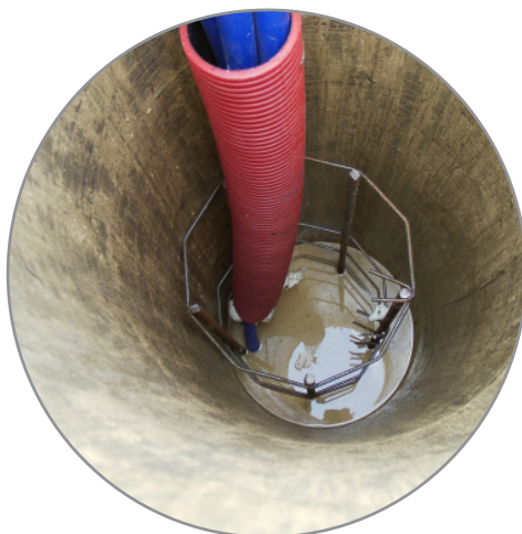
Préparation et mise en place des fondations thermoactives raccordées à la pompe à chaleur de la salle de concert
