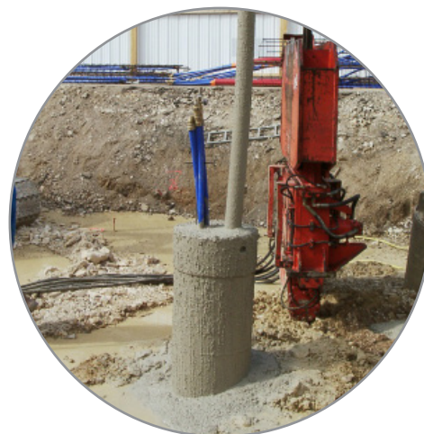
Préparation et mise en place des fondations thermoactives raccordées à la pompe à chaleur de la salle de concert
