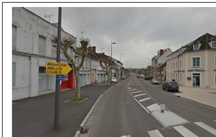
Habitations individuelles groupées secteur Ouest
