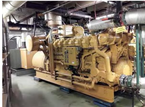
Figure 3 - Moteur rénové dans la centrale de cogénération
