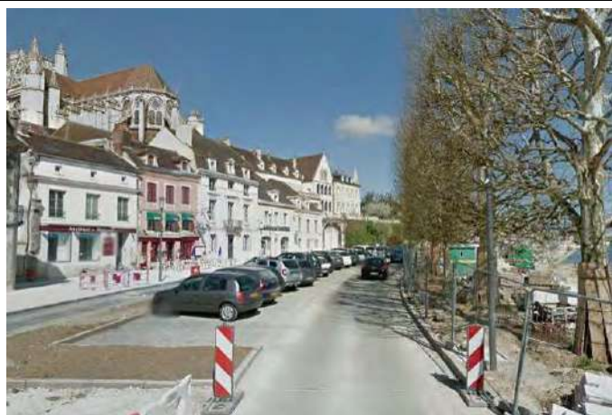
Habitations groupées secteur Nord
