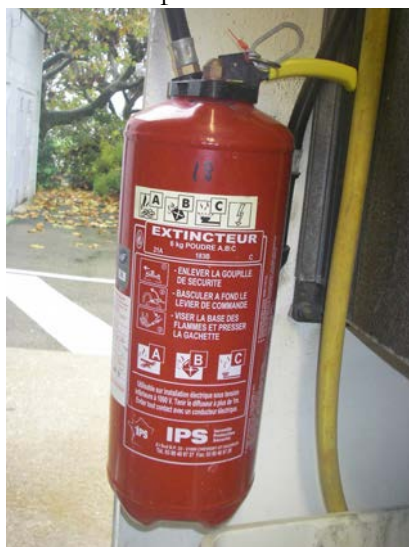
Extincteur poudre ou CO 2
