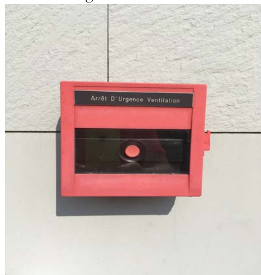
Arrêt d'urgence ventilation
