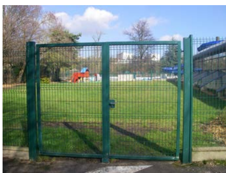
2 Accès pompiers grille été
