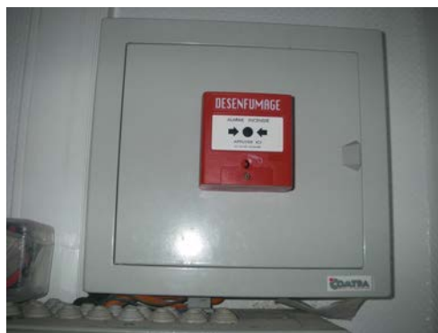
Commande désenfumage bassin 25m
